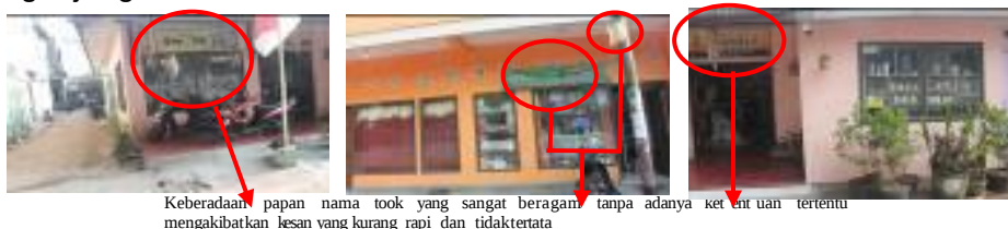
Gambar 11 Pemasangan signage yang tidak teratur
